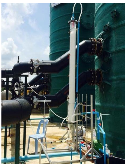
ภาพที่ 2 ระบบทำความสะอาดแก๊สชีวภาพ
