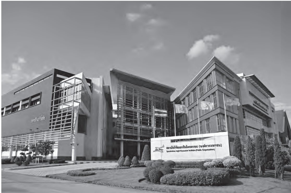
รูปที่ 1 อาคารสิรินธรวิจัยโซทัย สถานที่ตั้งของสถาบันวิจัยแสงซินโครตรอน จังหวัดนครราชสีมา
