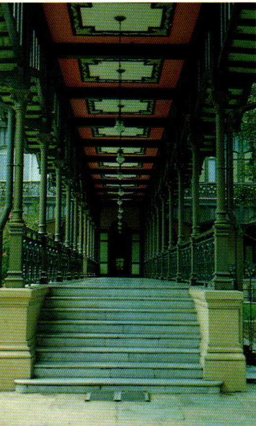
ทางเดินเชื่อมระหว่างพระที่นั่งอัมพรสถาน กับพระที่นั่งอุดรภาค มีโครงสร้างเป็นเสาเหล็ก ลูกกรงเป็นเหล็กหล่อ เพดานเขียนสีตาม ความนิยมของสมัยรัชกาลที่ ๕
