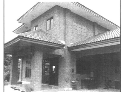
บ้านพักอาศัยบล็อกประสาน สองชั้น จ.หนองบัวลำภู
