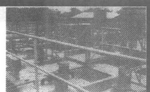
ทดสอบ และทดลองเดิน ระบบบำบัดน้ำเสีย
