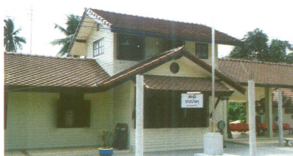
ผนังตีซ้อนเกล็ด สถานีรถไฟบางบำหรุ บางกอกน้อย
