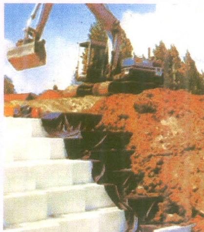
โฟมบล็อก และโฟมแผ่นใช้ในการก่อสร้างถนน สะพาน อาคาร สวิต โสม บล็อก ซีเมนต์บล็อกสอดไส้ฉนวนกันความร้อน
