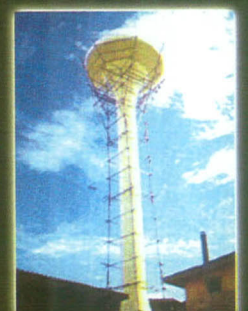
งานป้องกันสนิมถังน้ำหอสูง
