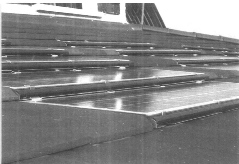
รูปที่ 5. บ้านที่ติดตั้งกระเบื้องพลังงานแสงอาทิตย์ใกล้ๆ เมืองสียง
