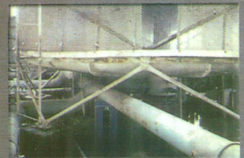
งานป้องกันสนิมท่อระบบความเย็น (COOLING TOWER)
