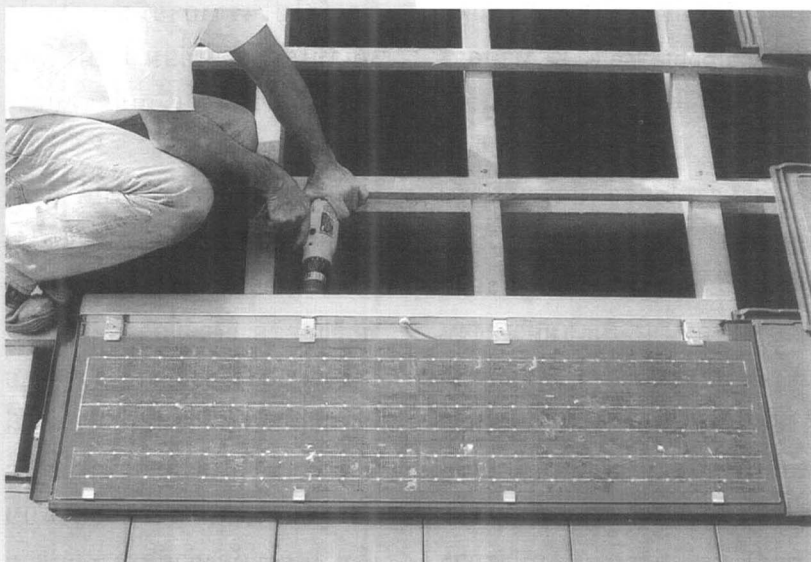
รูปที่ 4. การยึดกระเบื้อง
