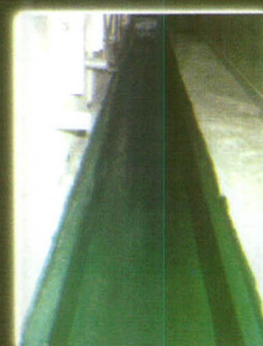
งานซ่อมรางระบายน้ำคอนกรีต ที่มีสารเคมีปนเปื้อนในน้ำเสีย
