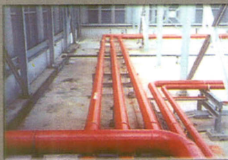
งานป้องกันการกัดกร่อน ท่อส่งน้ำ
