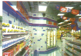
ผนังเปียก ร้านค้าภายในเมืองน้ำมัน JET
