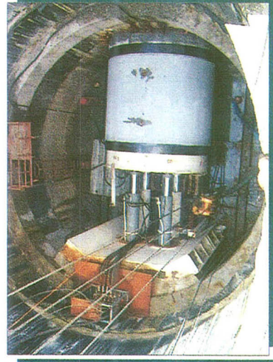
ผู้ผลิตท่อคืบได้คืบ Jacking Pipe ขนาดเส้นผ่าศูนย์กลาง 600 - 3000 มม. สำหรับโครงการบำบัดน้ำเสีย จังหวัดสมุทรปราการ
