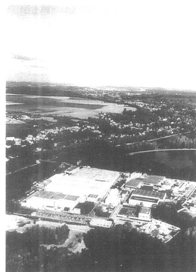
รูปที่ 1 : สถานีผลิตน้ำเมือง Méruy-sur-Oise; ระบบ Nanofiltration ชานเมืองปารีส - Générale des Eaux
