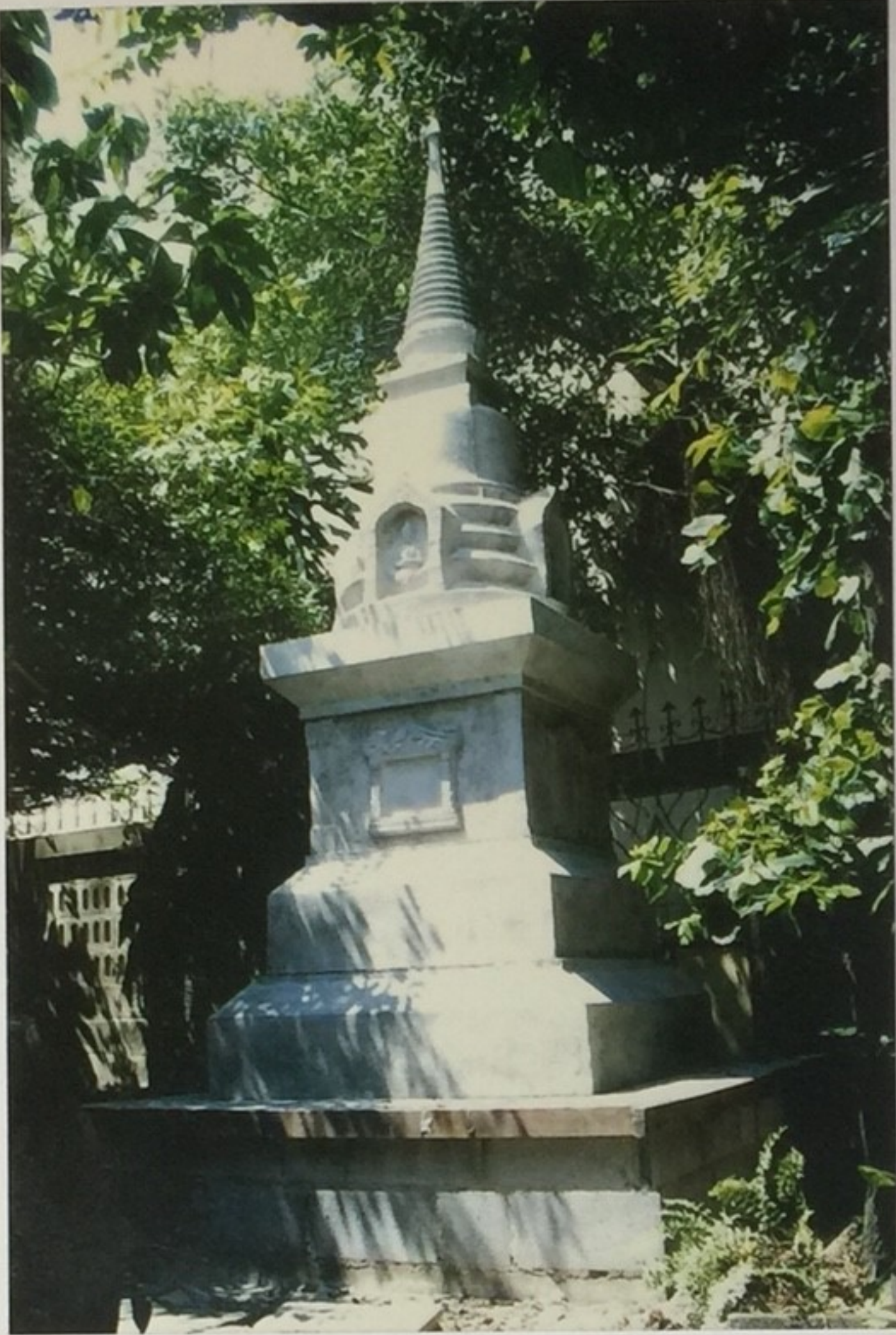
โครงสร้างหลัก ปูนซีเมนต์หล่อสำเร็จ ถอดได้แล้วนำมาประกอบขึ้นใหม่
