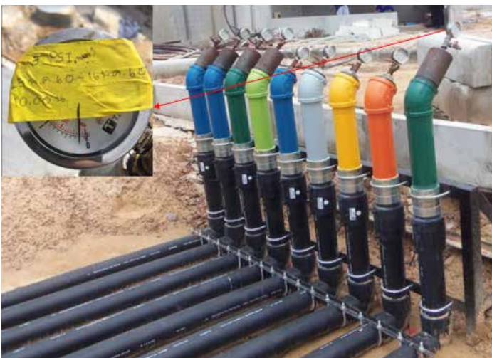
รูปที่ 2 การทดสอบการรั่วซึมของท่อและถังเก็บน้ำมันเชื้อเพลิงเหนือพื้นดินขนาดใหญ่ตามแนวนอน
