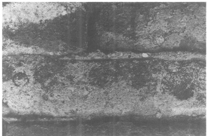
(บน) สภาพการผุเปื่อยของอิฐบนโบราณสถาน (ล่าง) จะพบผลึกเกลือบนผิวของอิฐมากในฤดูร้อน
