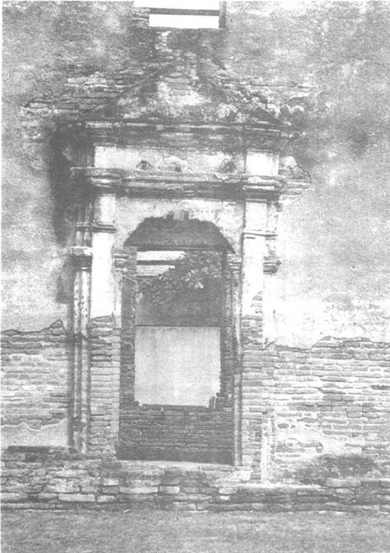
อิฐและปูนฝูเปียตามแนว ที่น้ำใต้ดินแทรกซึมขึ้นมา
