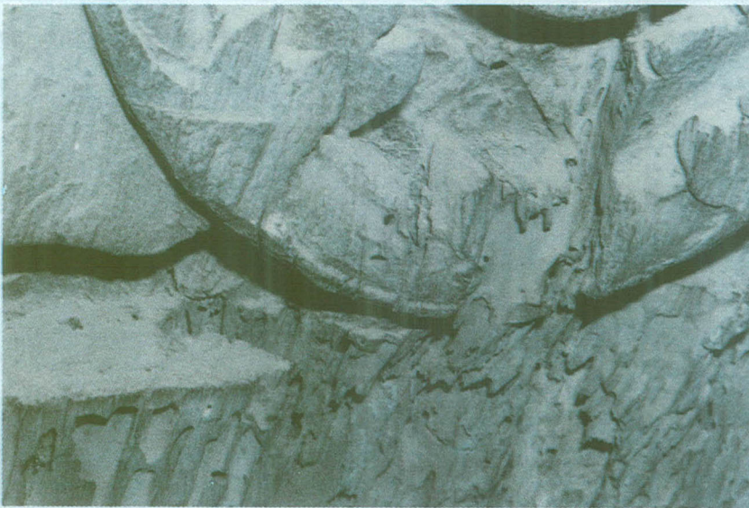
รูปที่ 3 ชิ้นส่วนหน้าบันไม้ ที่แสดงสภาพการชำรุดเพราะปลวก
