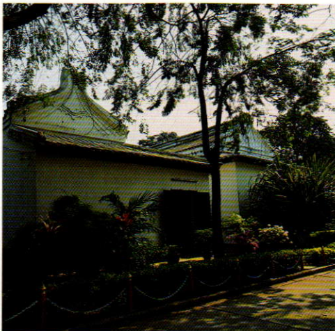
พระตำหนักเก๋งคู่ เป็นอาคารก่ออิฐถือปูน ๒ หลังคู่ ลักษณะสถาปัตยกรรมเป็นแบบจีน
