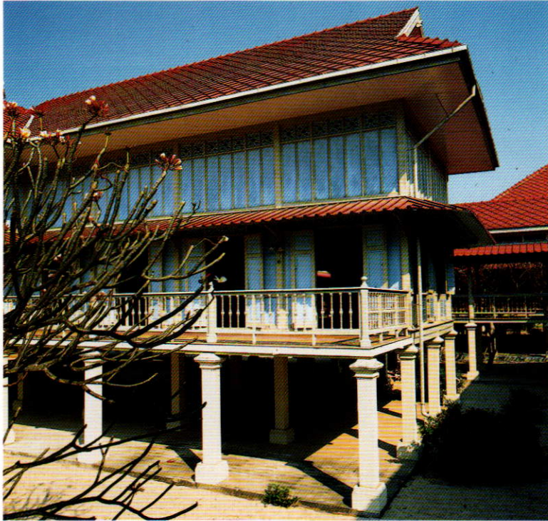
ตัวอาคารต่างๆ รับน้ำหนัก ด้วยเสาคอนกรีต ๑.๐๘๐ ต้น และมีลักษณะพิเศษคือ มีร่อง สำหรับหล่อน้ำที่โคนเสาทุก ต้น ป้องกันมดแมลงขึ้นอาคาร
