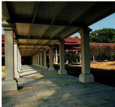
ตัวอาคารต่างๆ รับน้ำหนัก ด้วยเสาคอนกรีต ๑.๐๘๐ ต้น และมีลักษณะพิเศษคือ มีร่อง สำหรับหล่อน้ำที่โคนเสาทุก ต้น ป้องกันมดแมลงขึ้นอาคาร
