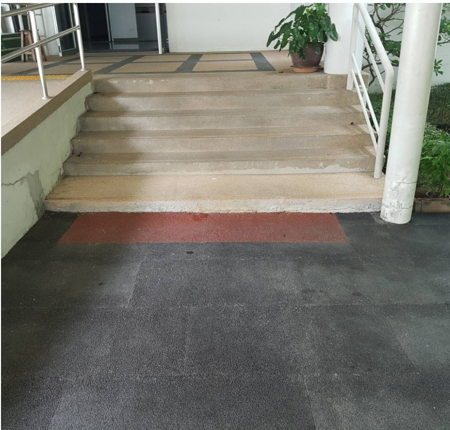
พื้นยางมะตอยสำเร็จรูป สำหรับปูเป็นทางเดิน และใช้สีต่างๆ เพื่อเตือนการเดิน สำหรับพื้นต่างระดับ
