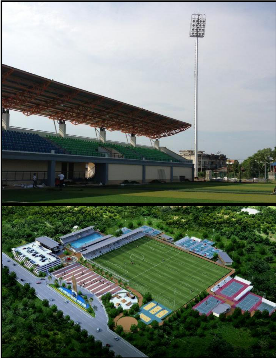
ภาพที่ 5.7 ศูนย์กีฬาประชาชนเทศบาลนครอุดรธานี
