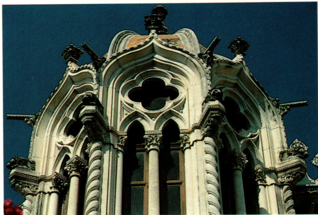
ด้านทิศตะวันตก เป็นห้องบันไดเวียนเล็ก ผนังภายนอก ๘ เหลี่ยม หลังคาโดมปั้น หน้าต่างคอนกรีตเป็นแบบโค้งแหลม และมีช่องแสงลายดอกไม้ตอนบนของหน้าต่าง ส่วนบนหัวเสาของโดมเล็กประดับด้วยปูนปั้นรูปสิงห์โตหมอบ
