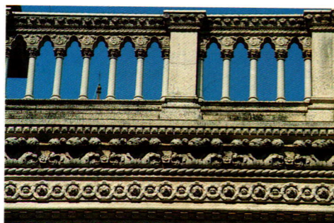
วัสดุที่ใช้ภายนอกอาคาร โดยทั่วไปเป็นหินล้างพิเศษให้เกิด รูปทรงเล็ก ๆ กำแพงผนังและบัวปูน ต่าง ๆ ตลอดจนผนังนอกบางส่วน ทาสีคล้ายกำแพงหินอ่อนสีกุหลาบ แบบวังเจ้านครเวนิส แต่ก็ดูกลม กลืนกันและดูประณีตงดงามเป็น อย่างยิ่ง
