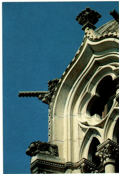
ด้านทิศตะวันตก เป็นห้องบันไดเวียนเล็ก ผนังภายนอก ๘ เหลี่ยม หลังคาโดมปั้น หน้าต่างคอนกรีตเป็นแบบโค้งแหลม และมีช่องแสงลายดอกไม้ตอนบนของหน้าต่าง ส่วนบนหัวเสาของโดมเล็กประดับด้วยปูนปั้นรูปสิงห์โตหมอบ
