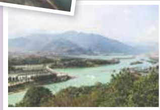
การขุดคลอง เชื่อมจินตอนเหนือและใต้
