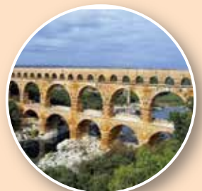
ท่อส่งน้ำ Aqueduct
