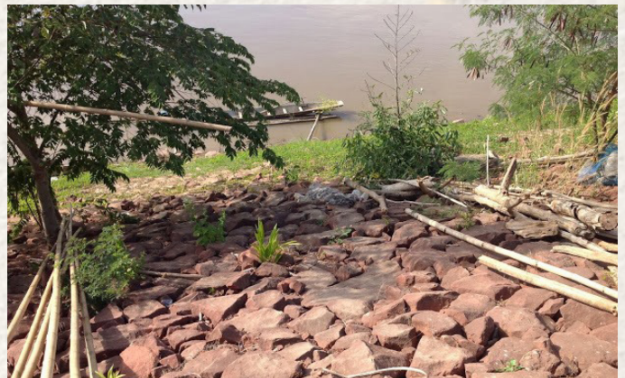
เขื่อนหินทรายป้องกันการกัดเซาะของแม่น้ำโขงในช่วงหน้าน้ำ
