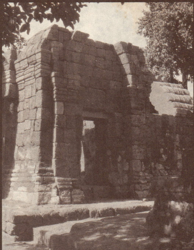
มุมหนึ่งในบริเวณปราสาท
