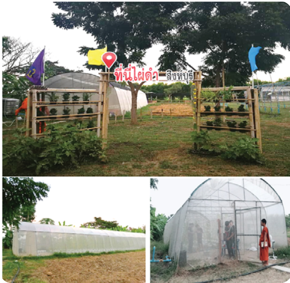
ภาพที่ 14 แสดงโครงสร้างโรงแมลอน โรงเรียนวัดไผ่ดำ
