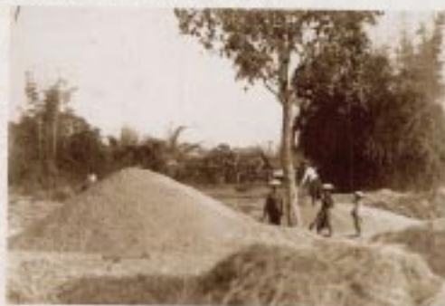
การก่อสร้างถนน สามพิจิตร-เพชรบูรณ์
