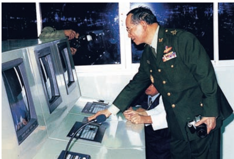
В день открытия дамбы Пасак Чонласит Король осматривает оборудование в помещении, откуда ведется управление дамбой.
