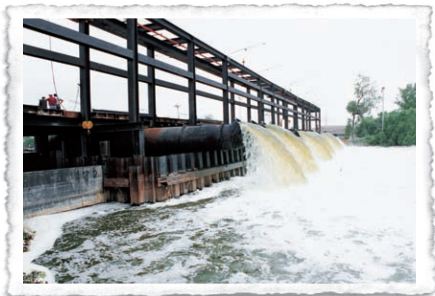
Шлюзы Махачай и насосная станция.
