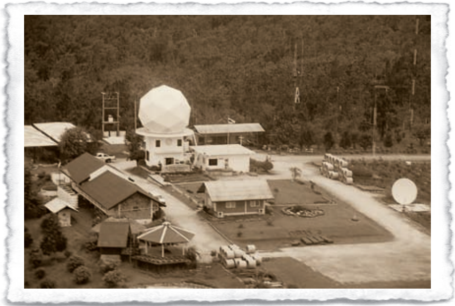
Королевская радарная станция, район Омкой, провинция Чиангмай.
