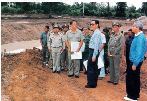
视察水源开发项目的工地。
