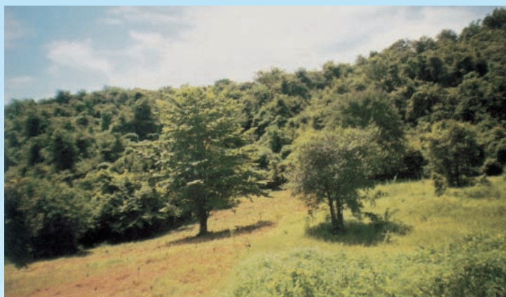
在流域区建起的可防洪蓄水的土路堤
