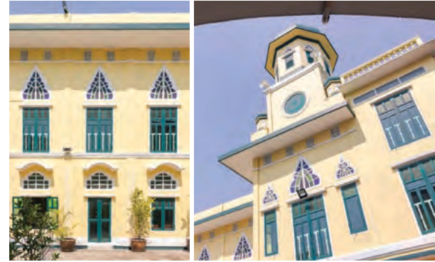
ห้องแสงประดับด้วยกระจกสี ทำเป็นรูปโดม มีกันสาดคอนกรีตเสริมเหล็กยื่นยาว ซึ่งเป็นเทคโนโลยีใหม่ นิยมทำกันในสมัยปลายรัชกาลที่ ๖ เป็นต้นมา
