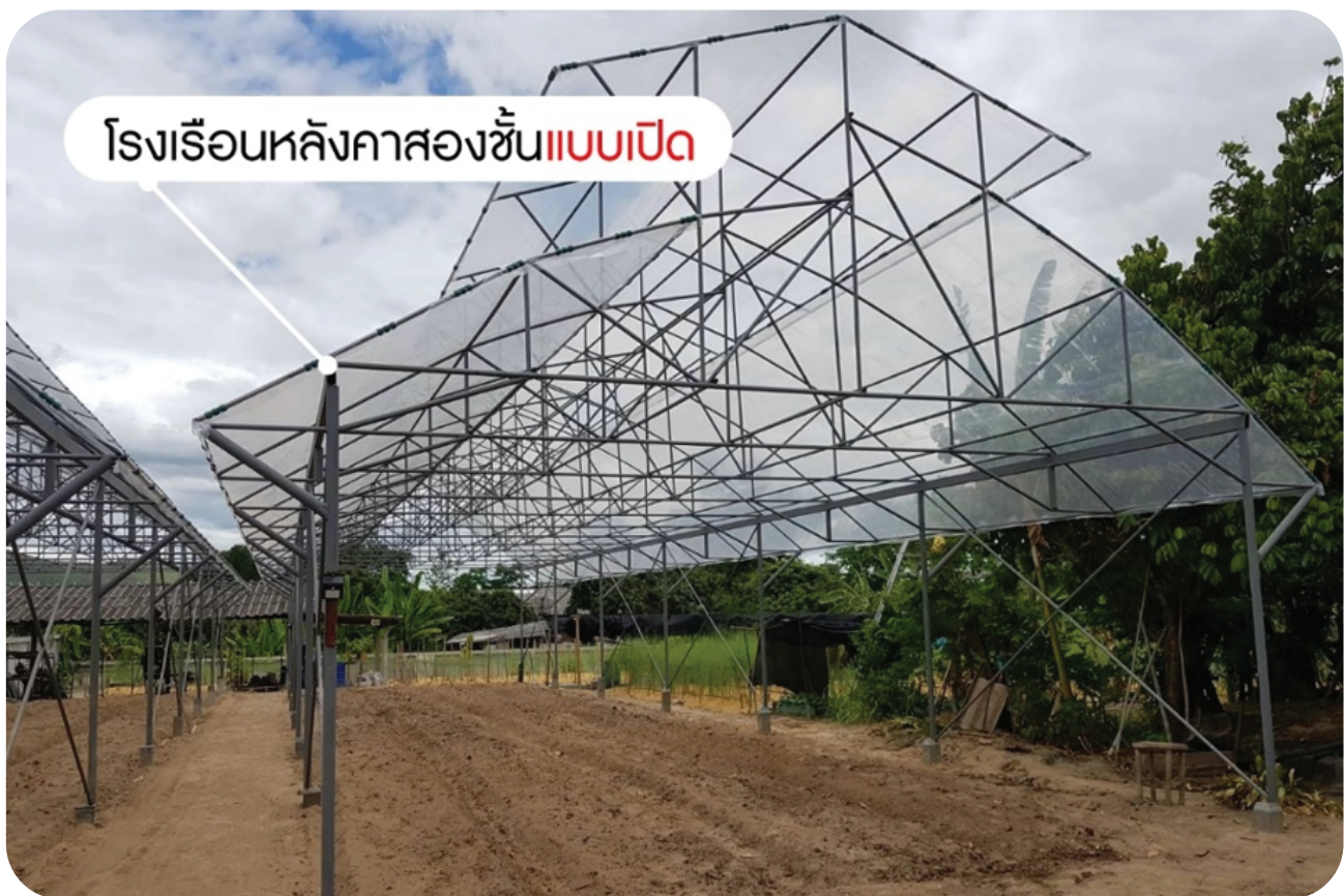
รูปที่ 1 โรงเรือนปลูกพืชโครงสร้างเหล็กแบบหลังคา 2 ชั้น ที่ สวทช. ออกแบบพัฒนาขึ้น
