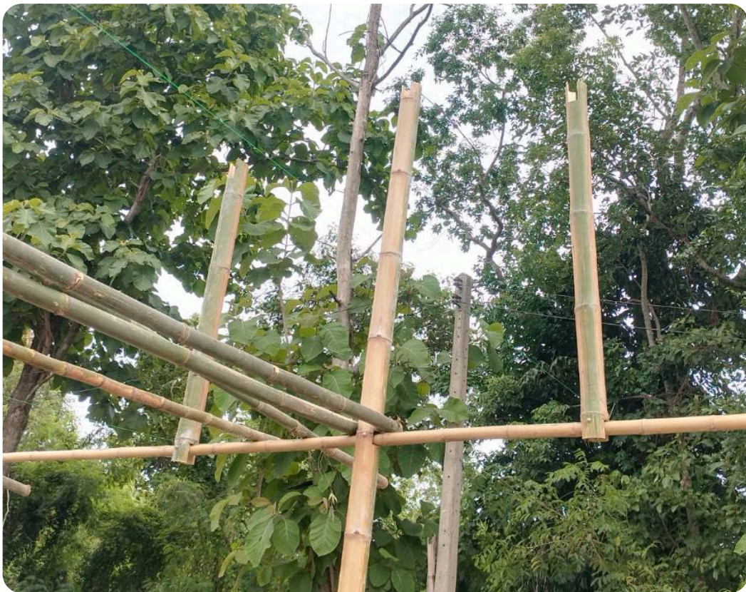
รูปที่ 12 การติดตั้ง
