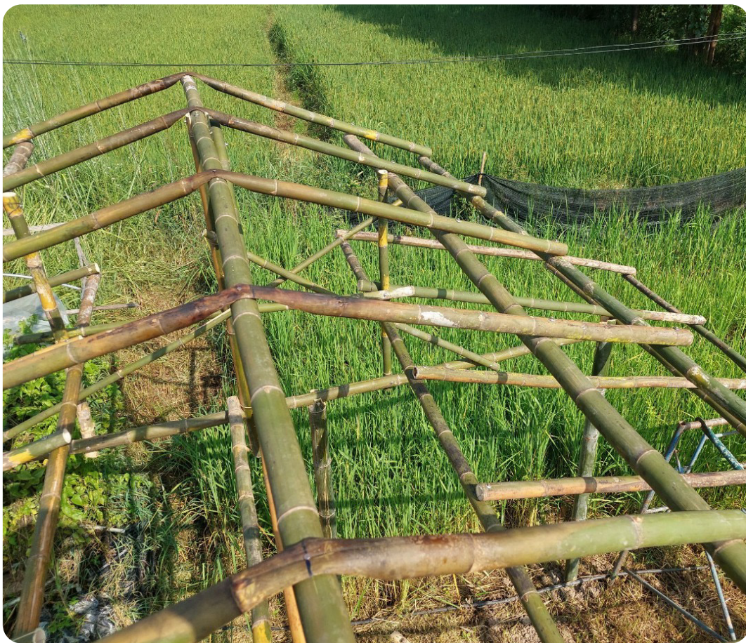
รูปที่ 18 การติดตั้งไม้กลอน
