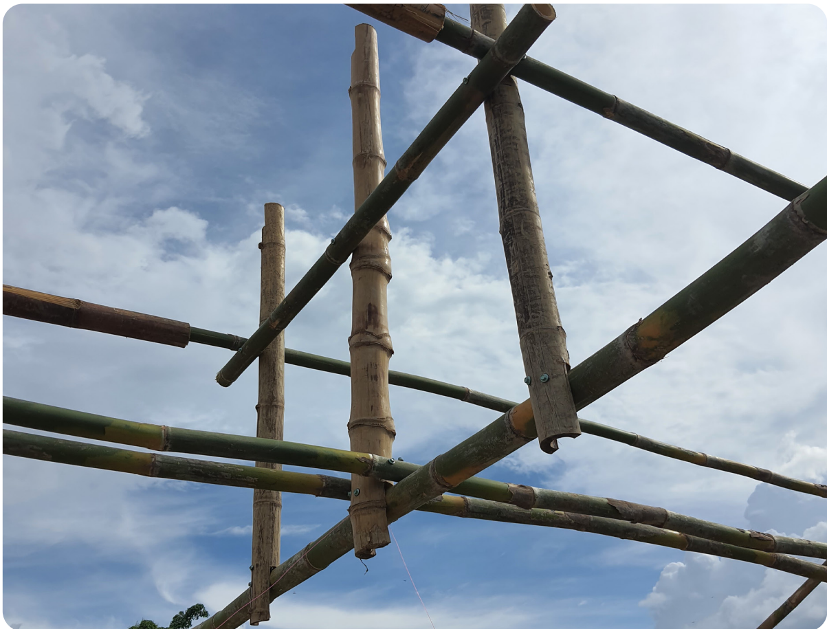
รูปที่ 14 การติดตั้งคานยึดตั้งซ้าย-ขวา
