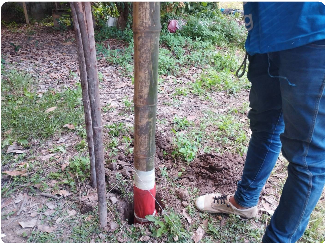
รูปที่ 10 การขุดหลุมและฝังเสา
