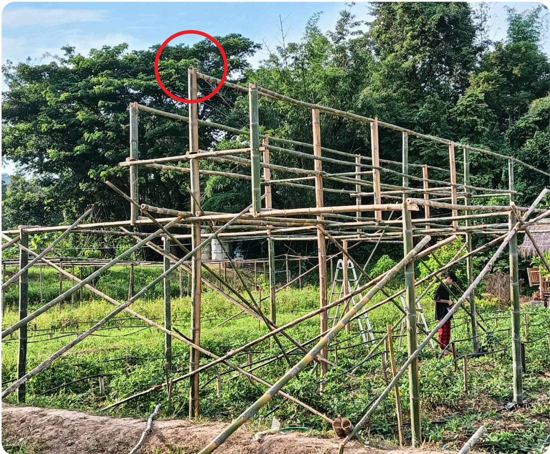
รูปที่ 17 การติดตั้งอกไก่ที่ยอดจั่วหลังคา
