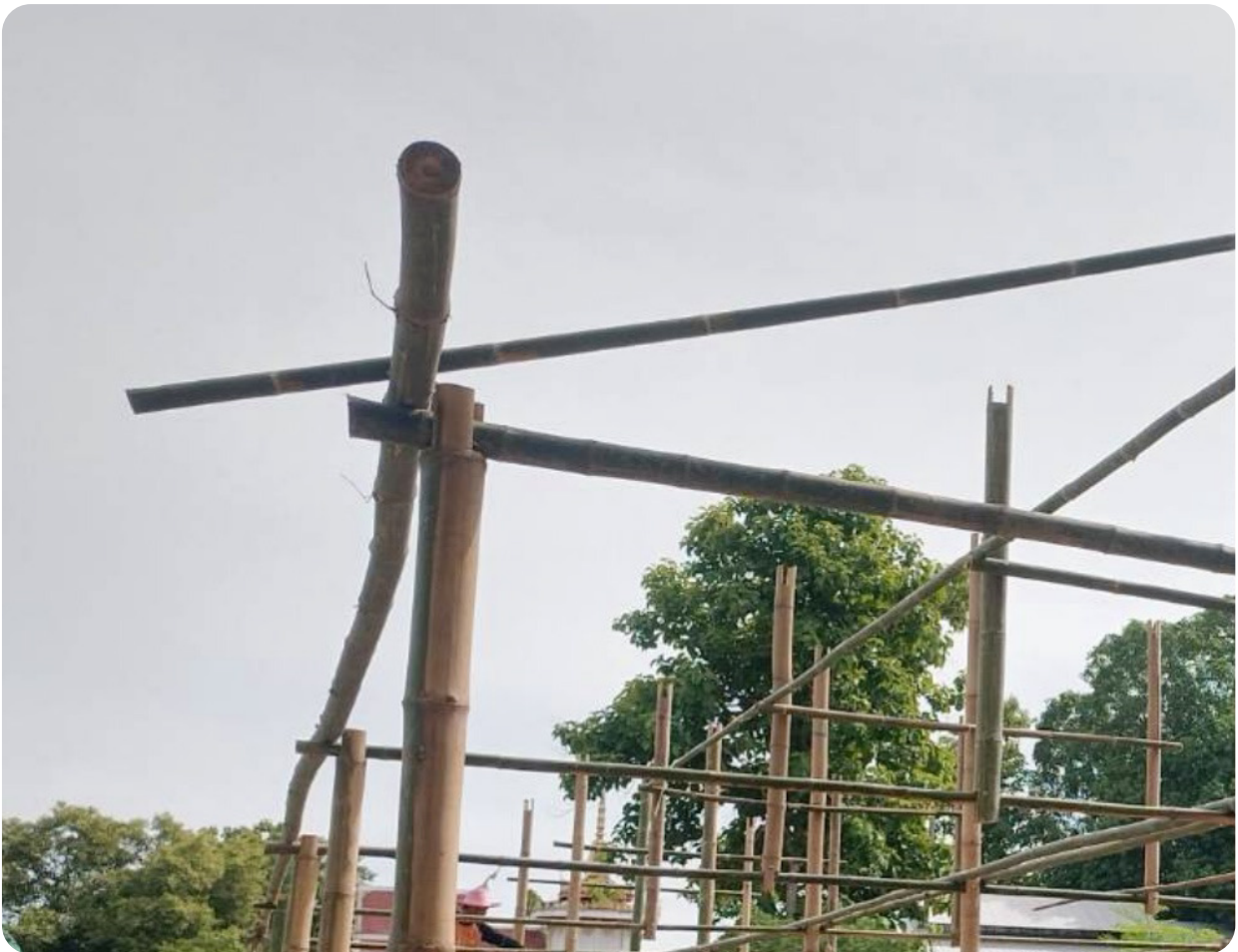
รูปที่ 15 การติดตั้งเสา
