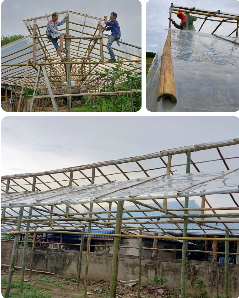
รูปที่ 21 การติดตั้งแผ่นหลังคาพลาสติก
