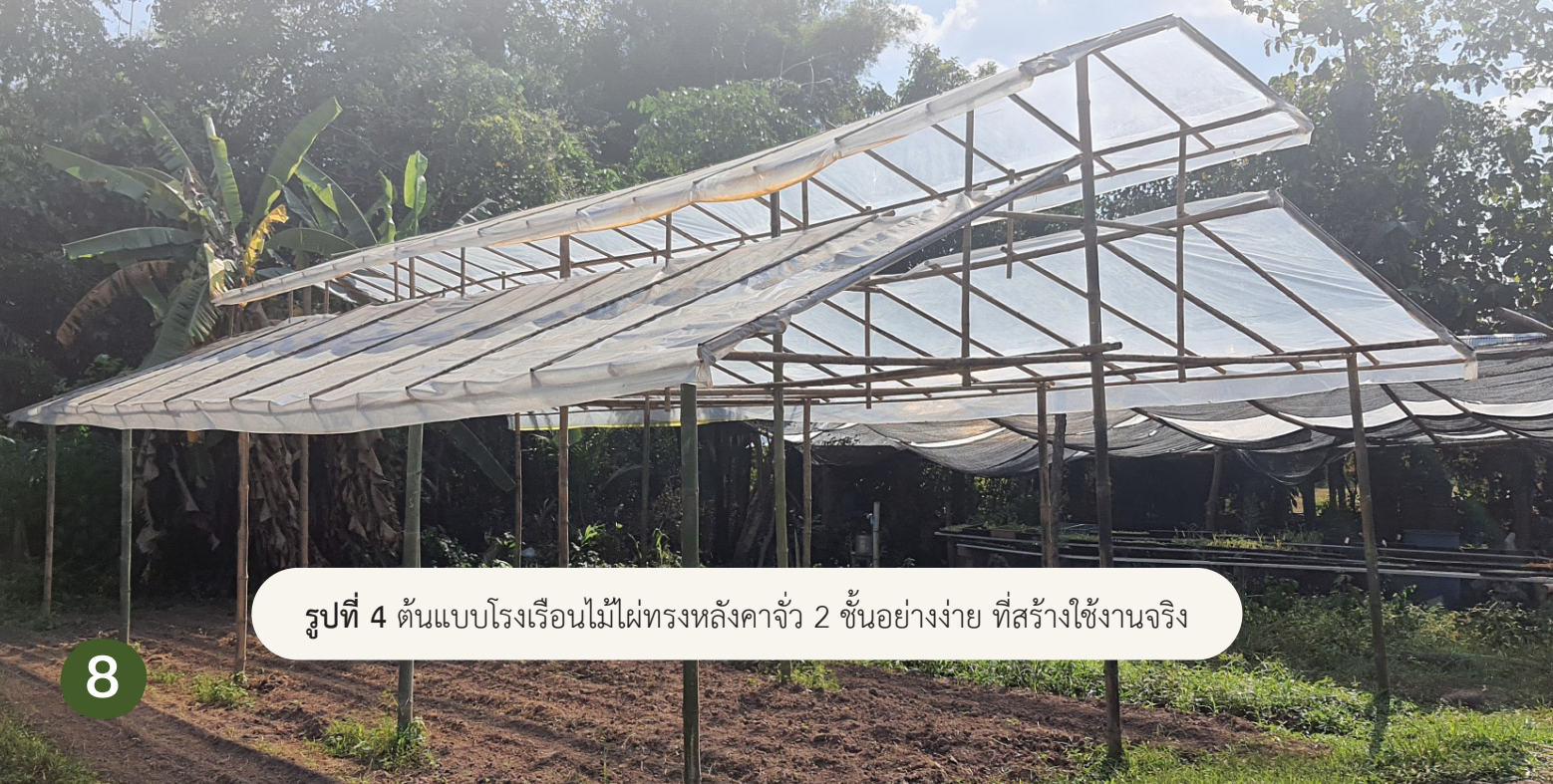
รูปที่ 3 แบบโรงเรือนปลูกพืชไม้ไผ่ทรงหลังคาจั่ว 2 ชั้นอย่างง่าย หน้ากว้าง 4 เมตร (ซ้าย) และ 6 เมตร (ขวา) ที่ปรับปรุงแบบใหม่เพื่อลดต้นทุนลงและสร้างได้ง่ายขึ้น
