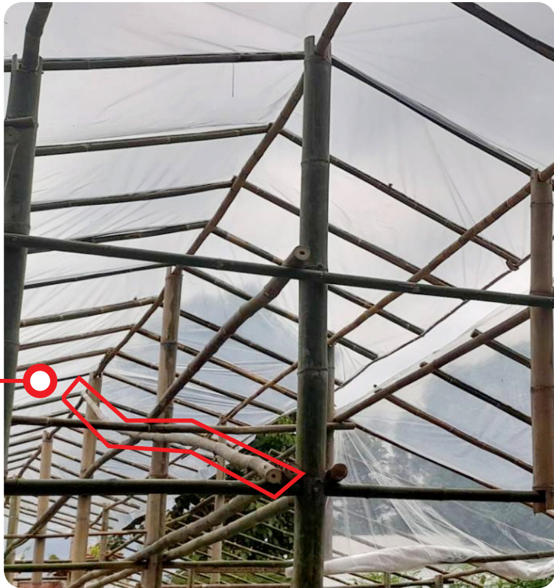
รูปที่ 20 การเสริมไม้ตามตามจุดต่างๆ เพื่อเพิ่มความแข็งแรงให้โรงเรือน
