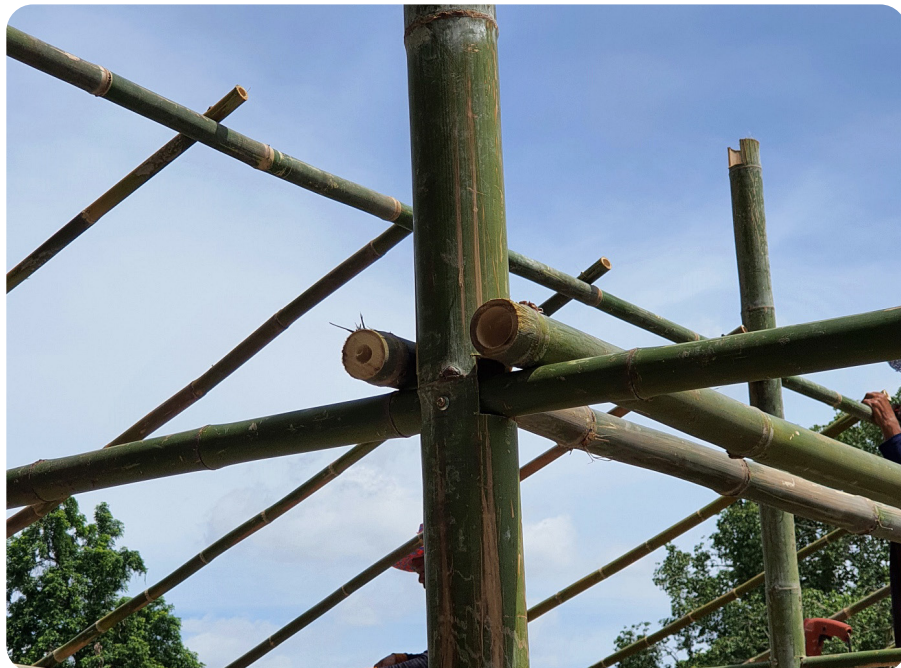
รูปที่ 13 การติดตั้งคานยึดตั้งตามแนวยาวโรงเรือน
