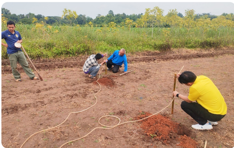
รูปที่ 9 แบบการปรับที่ดิน วัดระยะและกำหนดจุดขุดหลุมฝังเสา
