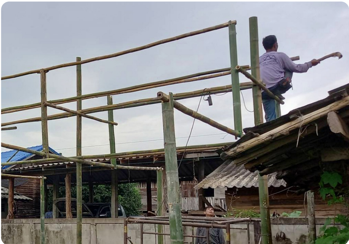
รูปที่ 16 การติดตั้งแปหลังคา
