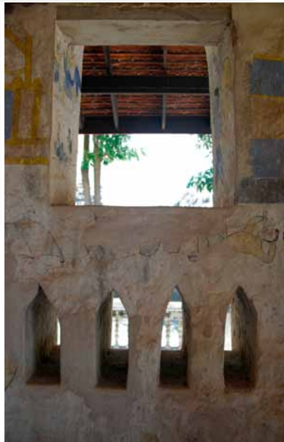
ช่องหน้าต่าง และช่องลม ช่วยระบายอากาศภายในโบสถ์
