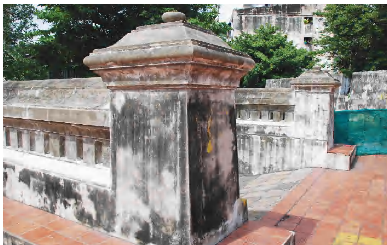
ป้อมป้องปัจจามิตร เขตคลองสาน กรุงเทพมหานคร
