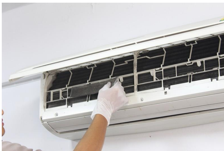
รูปที่ 10-16 การทำความสะอาดฟیلเตอร์กรองอากาศหรือแผงคอยล์เย็น
