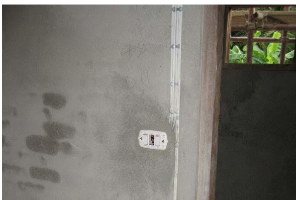
รูปที่ 10-1 การเดินสายไฟฟ้าในอาคารแบบเปิด (เดินลอย)
