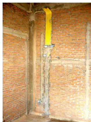
รูปที่ 10-2 การเดินสายไฟแบบปิด แบบซ่อนสายในท่อ
