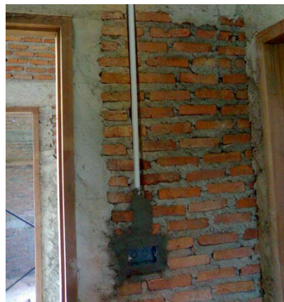
การเจาะผนังเพื่อวางตำแหน่งท่อร้อยสายไฟ
