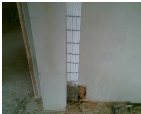
รูปที่ 10-1 การเดินสายไฟฟ้าในอาคารแบบเปิด (เดินลอย)
