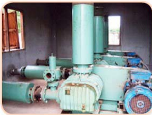
รูปแสดงก่อนการปรับปรุง
