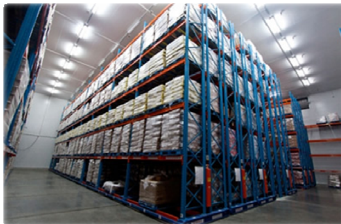
รูปที่ 8-10 ห้องเย็นแบบการพาความร้อน (ห้องเย็นในห้างสรรพสินค้า)
