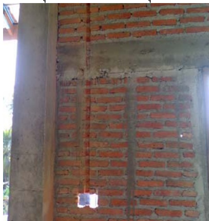
การเจาะผนังเพื่อวางตำแหน่งท่อร้อยสายไฟ
