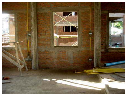
รูปที่ 10-2 การเดินสายไฟแบบปิด แบบซ่อนสายในท่อ
