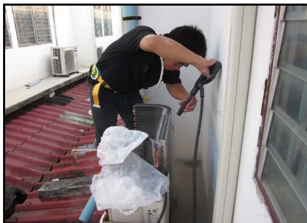
รูปที่ 13-43 ขั้นตอนการล้างชุดคอนเดนเซอร์
