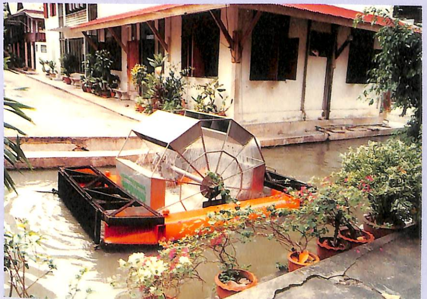
กังหันน้ำชัยพัฒนา ใช้บำบัด น้ำเสียบริเวณวัดบวรนิเวศวิหาร
