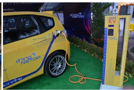
หัวจ่ายชาร์จแบตเตอรี่รถยนต์ไฟฟ้าสามารถใช้บัตรแตะเพื่อเปิดใช้งานการชาร์จแบตเตอรี่รถยนต์ไฟฟ้าต้นแบบ
