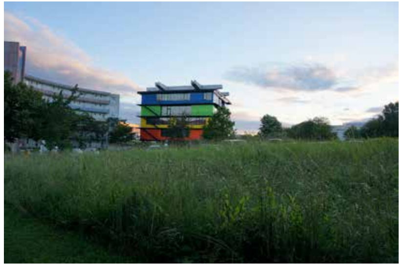
อาคาร XLAB สถานที่เข้าค่าย
