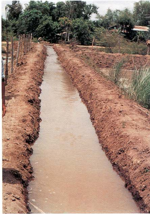
ภาพที่ 11 การจัดการน้ำในพื้นที่ดินเปรี้ยวจัดโดยทำคูคลองระบายน้ำ
