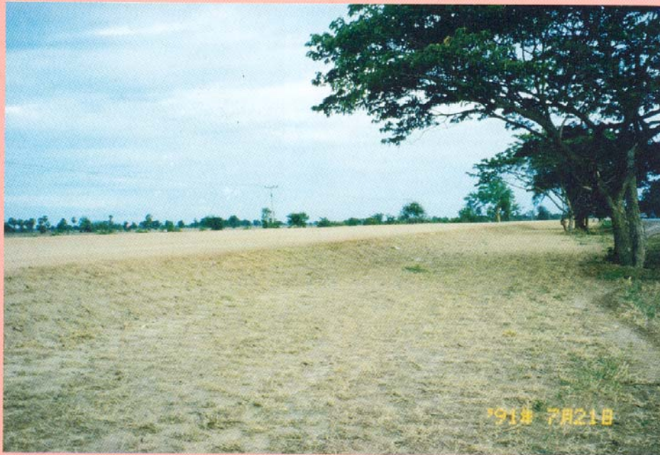
รูปที่ 1 ลักษณะดินถมหรือดินคันทาง (Roadfill or subgrade)
