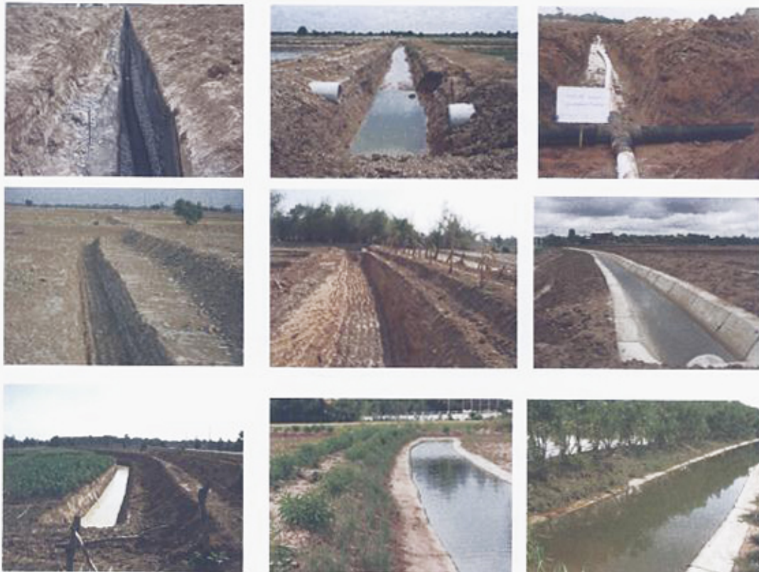
ภาพที่ ๔.๕ การก่อสร้างระบบระบายน้ำใต้ดิน (*Sub drain)
