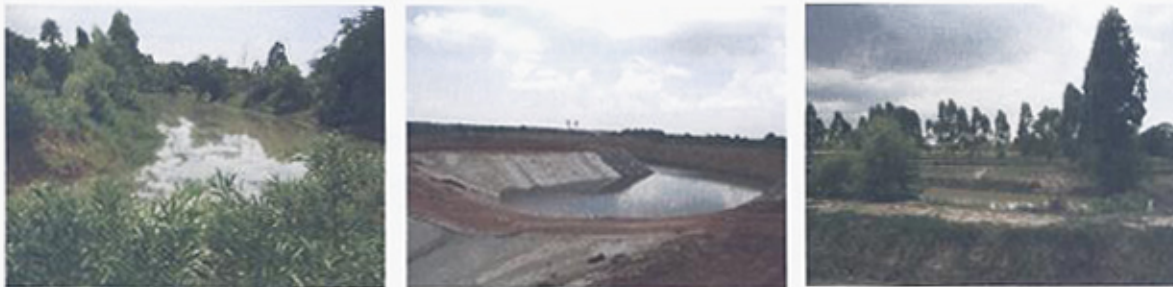
ภาพที่ ๔.๗ การขุดลอกทางระบายน้ำธรรมชาติ
