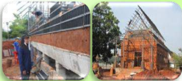
การทำผนังดินแบบบดอัดในอาคารที่ก่อสร้างจริง โครงการสร้างโบสถ์ดินวัดตออย่าง จ. สระบุรี มหาวิทยาลัยเทคโนโลยีราชมงคลตะวันออก วิทยาเขตอุเทนถวาย
