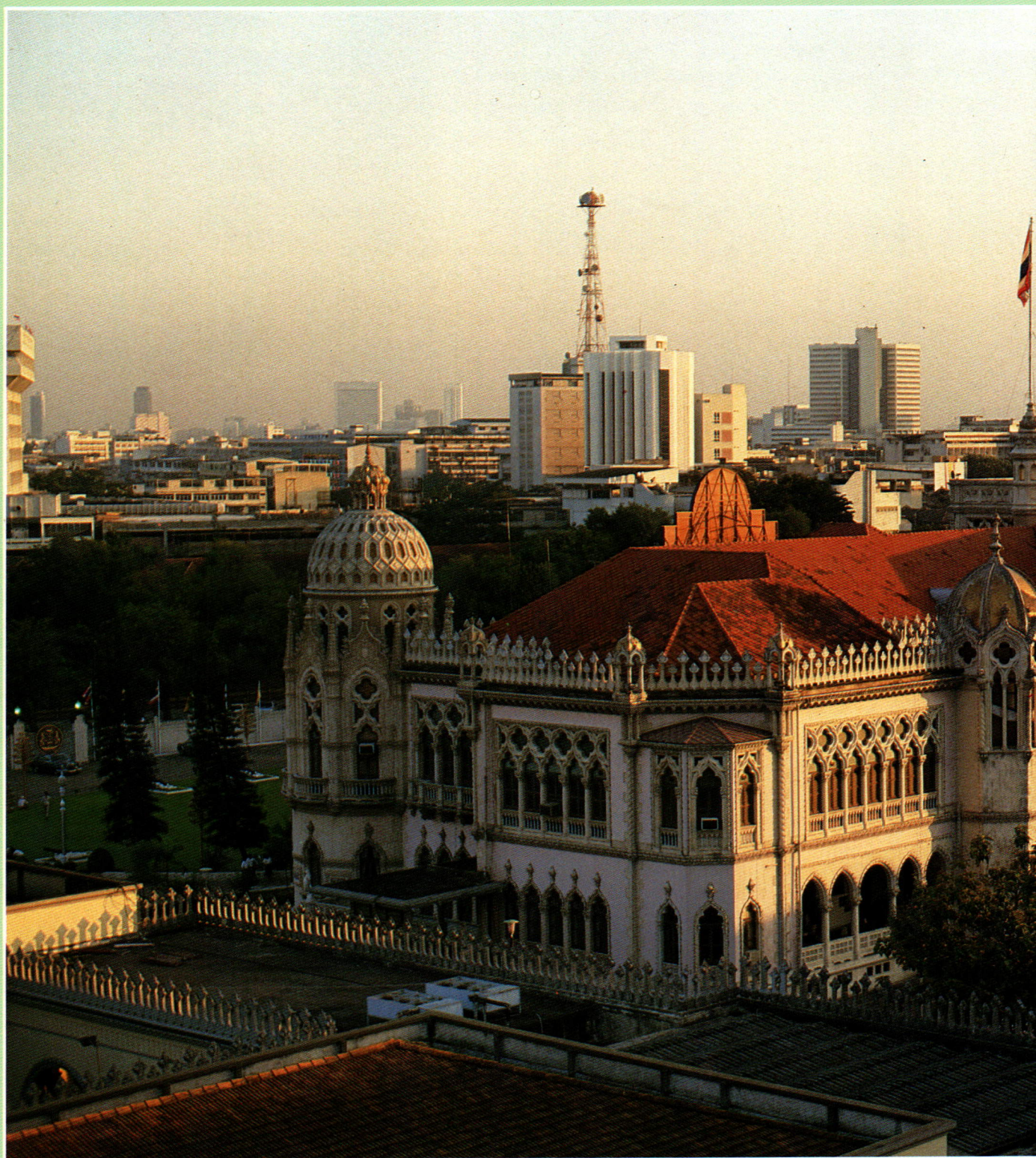
หลังคาของตึกไทยคู่ฟ้า เป็นหลังคาคลุม และมุงด้วยกระเบื้องสีเคลือบหน้าวาวสีอิฐ
