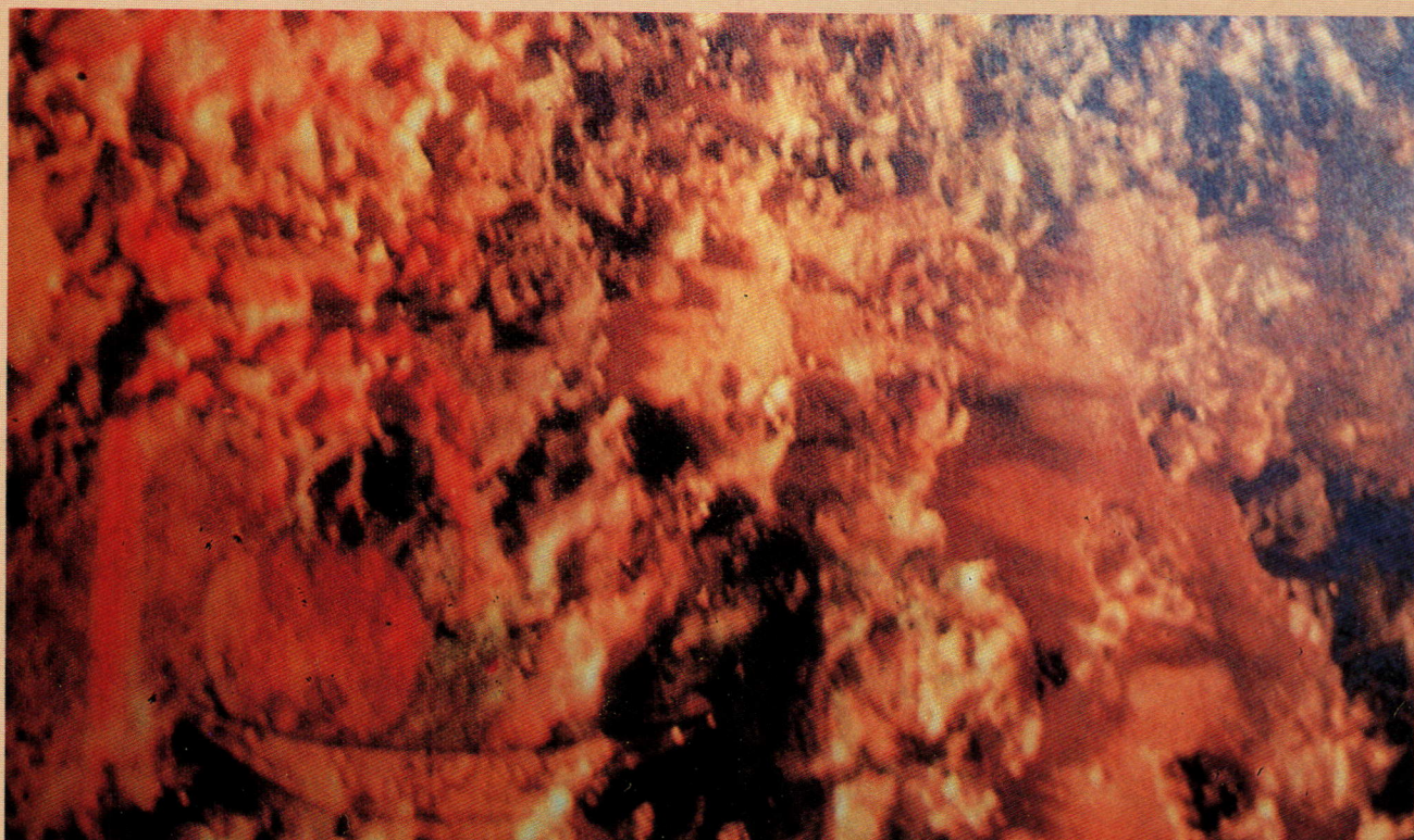
ภาพ ความขรุขระของชั้นสีของจิตรกรรม ฝาผนัง ในพระอุโบสถ วัดราชโอรสาราม ก่อนการฉีกชั้นสีและการทำความสะอาด ชั้นสีโป่งพองและอ่อนนุ่ม ใกล้เคียงหลุดร่วงไป เป็นพื้นที่กว้างใหญ่มาก
