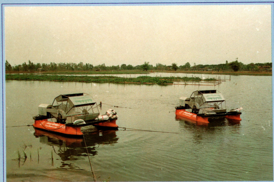
กักหน้ำขั้พัฒนา เครื่องกลเติมอากาศที่ผิวน้ำ
