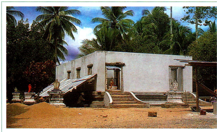
วัดปะ ตำบลท่าดี อำเภอลานสกา จังหวัดนครศรีธรรมราช ซึ่ง นายสุก-นางขลิบ บิดามารดาของหลวงวินิจทัศนกรรม (บั้ง ติณสูลานนท์) ถวายการอุปถัมภ์มาแต่ครั้งอดีต ขณะนี้คณะญาติและพุทธบริษัท ได้ถวายเงินจำนวนหนึ่ง เพื่อบูรณะพระอุโบสถ (ในภาพกำลังบูรณะ)
