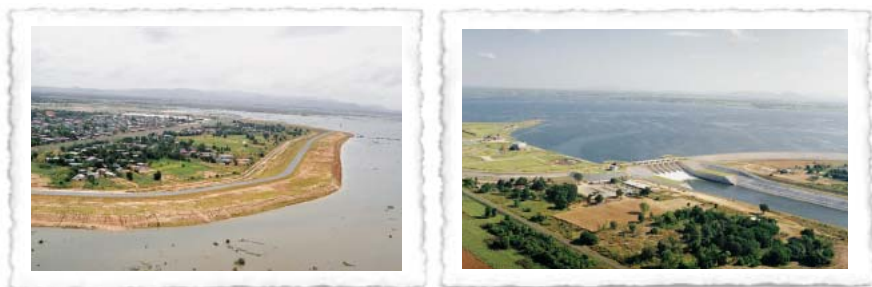
Der Pa Sak Jolasid Staudamm an der Nahtstelle des Distriktes von Phatthana Nikhom in der Provinz Lop Buri und des Distriktes von Wang Muang in der Provinz Saraburi, beide Zentralthailand : Teil des Erddammes (links) und das Stauwehr (rechts).
