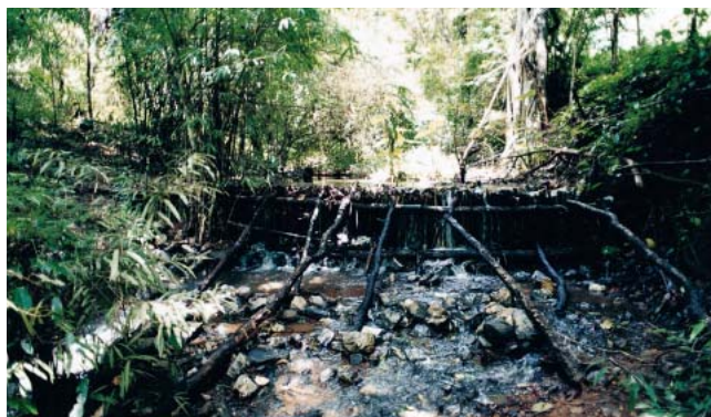
Ein zum Aufstauen von Hangwasser zwecks Steigerung der Feuchtigkeit in einem Forst angelegtes Wehr aus Erde und Krummholz auf dem Gelände des Königlichen Entwicklungsstudien-Zentrums, Sun Sueksa Kanphatthana Anuengmachak Phra Rachadamri auf thai sowie offiziell Royal Development Study Centre genannt auf englisch, in Huai Hong Khrai, Doi Saket Distrikt, Chiang Mai Provinz, Nordthailand.
