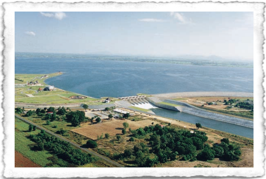
The Pa Sak Jolasid Dam.
