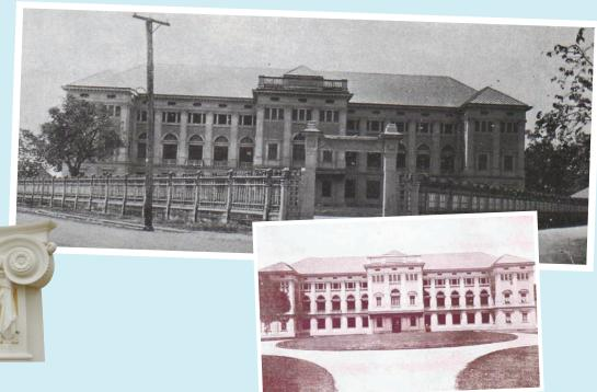
อาคารที่ทำการกระทรวงพานิชย์สูง ๓ ชั้น ก่ออิฐถือปูน ทาสีเหลืองอ่อน โครงสร้างอาคารเป็นแบบ ผสมระหว่างระบบผนังรับน้ำหนัก (Wall Bearing) ซึ่งเป็นเทคนิคโบราณ กับระบบเสา-คาน (Post and Lintel) มีการใช้คอนกรีตเสริมเหล็กเป็นวัสดุหลัก ซึ่งเป็นเทคนิคการก่อสร้างสมัยใหม่ ในขณะนั้น โครงสร้างของตัวอาคารจึงมีความสำคัญในฐานะรอยต่อทางประวัติศาสตร์สถาปัตยกรรม ยุคเปลี่ยนผ่านจากระบบการก่อสร้างแบบโบราณมาสู่ยุคสมัยใหม่
