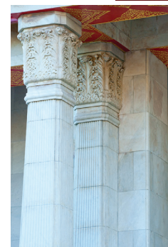
เสารับมุขด้านหน้าเป็นเสาหินอ่อนทรงเหลี่ยมเข้ระรองสลักเป็นลายหัวเสาอย่างฝรั่ง
