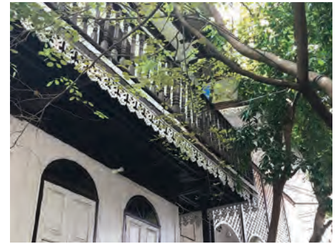
ระเบียงไม้ชั้นสอง เจาะเป็นช่องประตูโดยรอบ เพื่อเปิดเข้าไปยังห้องภายในเรือนได้อีกด้วย
