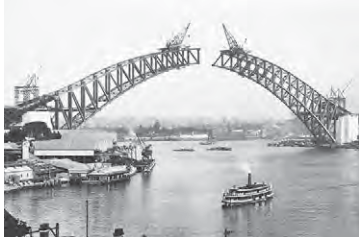
สะพานข้ามอ่าวซิดนีย์ ประเทศออสเตรเลีย ขณะก่อสร้าง
